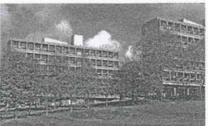
ロンドン郊外の公営住宅 2012年4月21日(小玉純一撮影)
